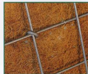
Bild 3: Erosionsschutz- und Begrünungsmatte aus Kokosfasern hinter der Frontfläche
