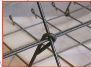
Bild 2: Verbindung der vorgeformten Drahtmatte mit dem Bewehrungsgitter mittels Steckstab
